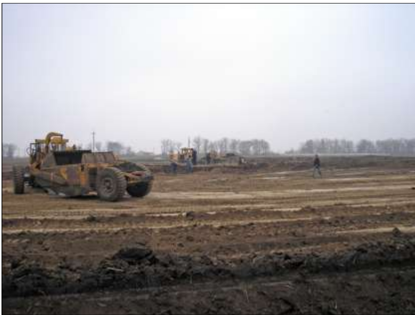
Для исследования могильника был использован метод сплошного вскрытия площади.
